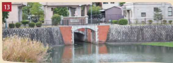
第2疏水取水口と洞門
