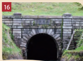
第1トンネル出口
