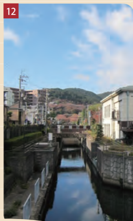
第1疏水取水口
