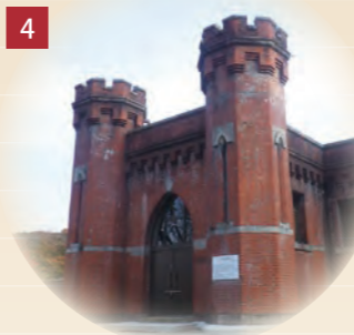
4 蹴上浄水場 第1高区配水池
