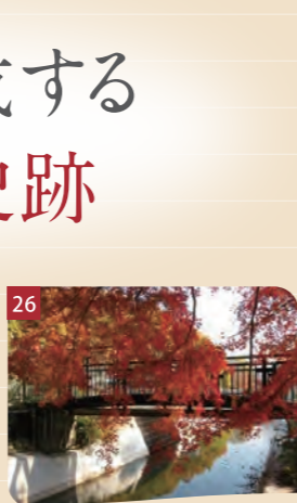
日ノ岡第11号橋
