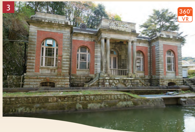
3 旧御所水道ポンプ室
