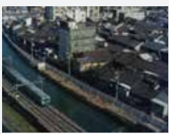
五条大橋南側から(京阪本線地下化前。昭和63年頃)
